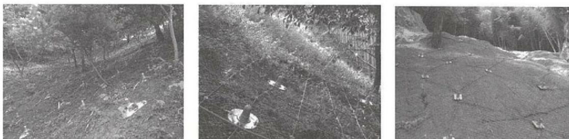
写真 10-3 ワイヤロープ併用型 (例)
