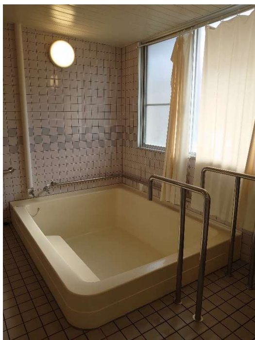
⑥-2 1号棟浴室内（浴槽部分）
