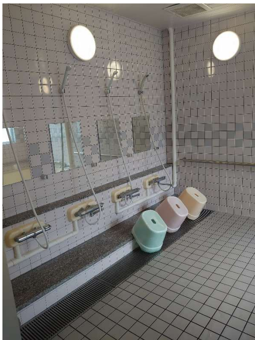
⑥-1 1号棟浴室内（シャワー部分）
