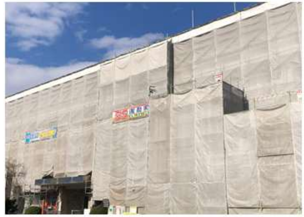
外壁改修工事中の本館 (R5.11)
