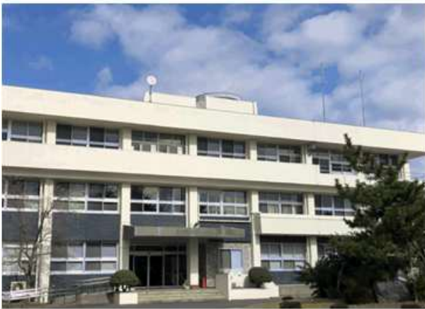
外壁改修工事完了後の本館 (R6.3)
