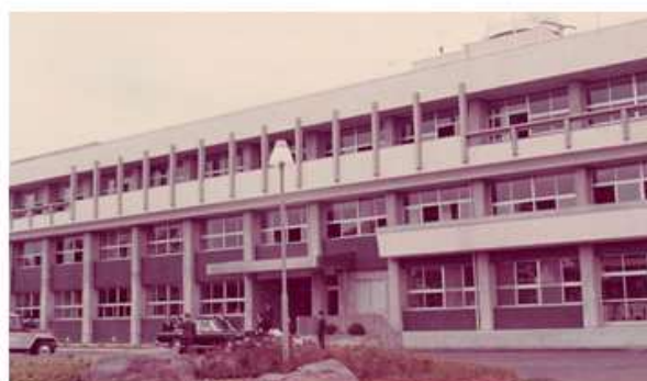
竣工当時の本館
