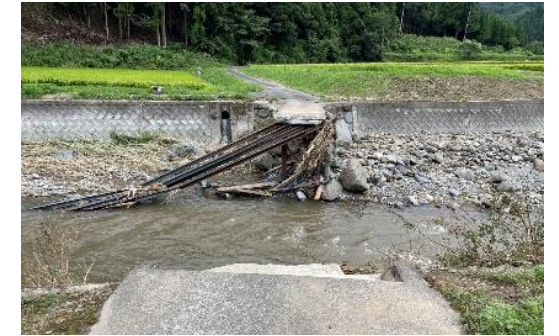
[農道橋の流出<八頭町落岩>]
