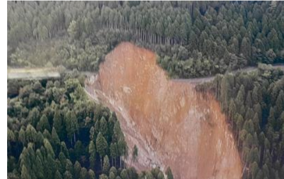
[林道の崩壊<鳥取市河原町赤井谷>]
