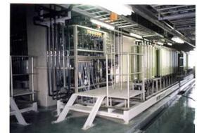
◆ 水だけを透過する半透膜（RO膜）で、浸出水を加圧ろ過する処理方式
