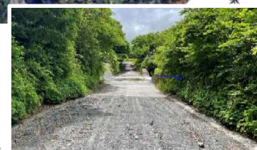
↑旧道（交通開放時は舗装を行う）
