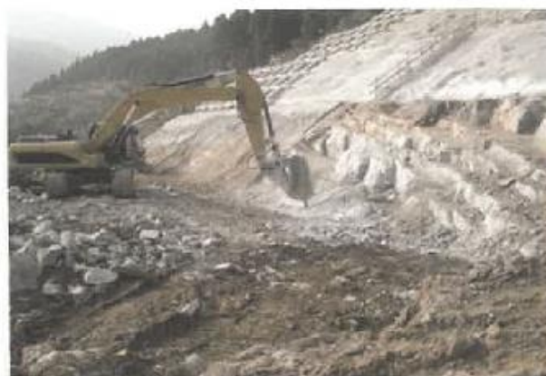
大型ブレーカーによる掘削作業状況
