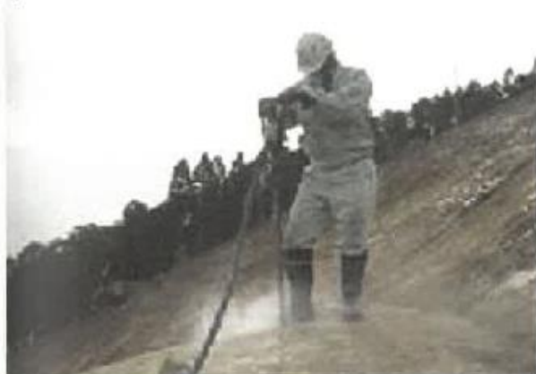
人力による掘削作業状況
