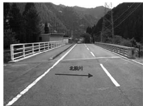
終点側→起点側
