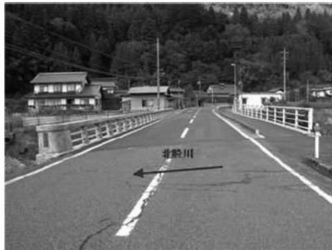
起点側→終点側
