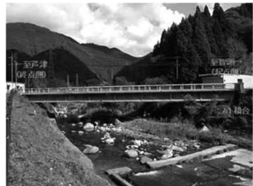
下流側→上流側
