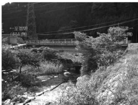
上流側→下流側
