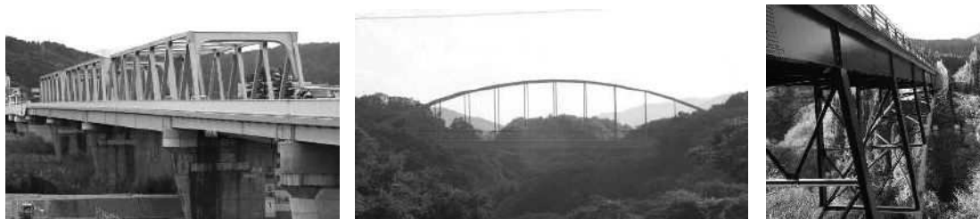
天神橋：トラス（下路）
