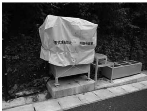
凍結防止剤散布装置
