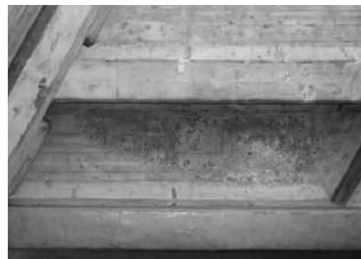
(コンクリート) 黄色っぽく変色している。
