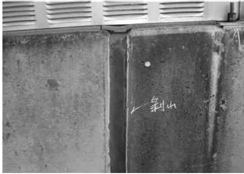
(その他) 防護柵の目地材が剥がれている。
