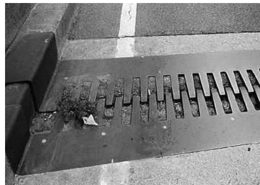
伸縮装置の遊間に土砂詰りが生じている。
