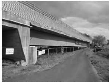
東北自動車道 大森川橋
