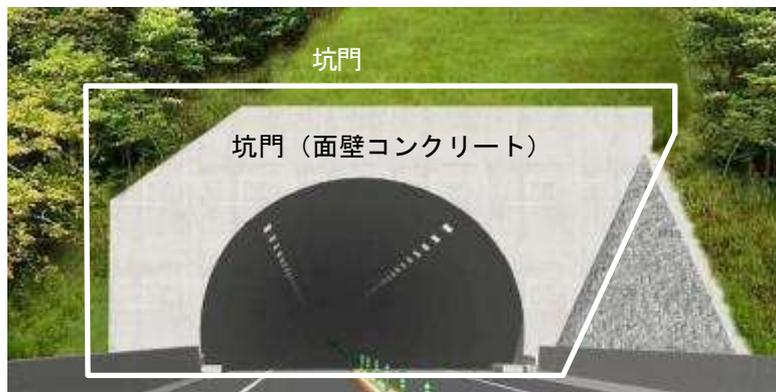
図一解5.4 標準的な点検対象箇所（トンネル坑口部）
