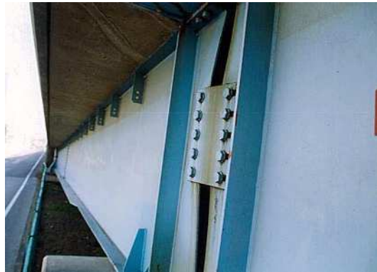
部材が局部的に著しく変形している。
