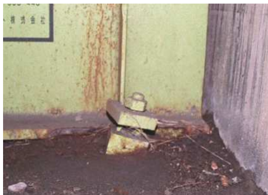
パターン 6、7 支承の傾斜 大量の土砂堆積
