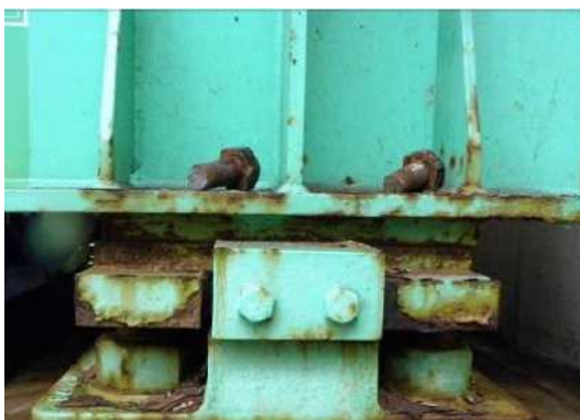
パターン 5 アンカーボルトが破断している。
