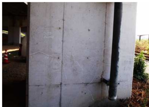
軽微なひびわれが生じている。
