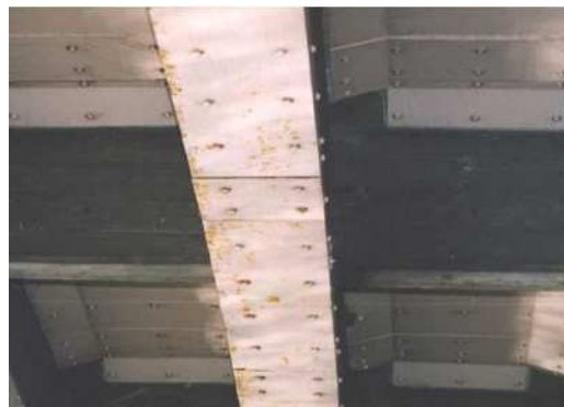
うきは発生していないものの、錆が見られる。
