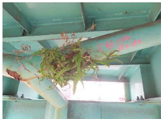
排水管に土砂詰りが生じている。
