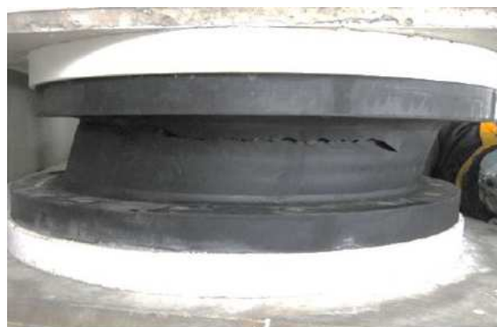
パターン 4 ゴム支承の破損・異常な変形が生じている。
