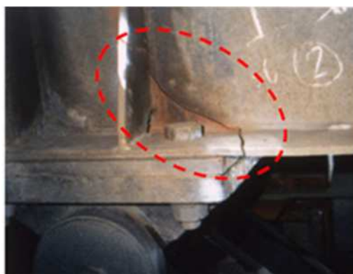
亀裂が生じている。
