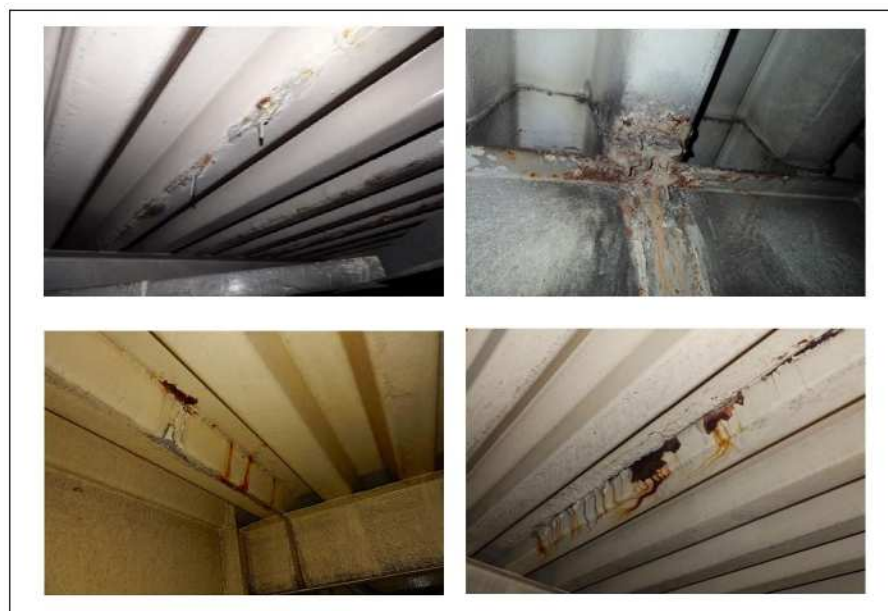
床版（デッキプレート）に漏水がある場合の例
