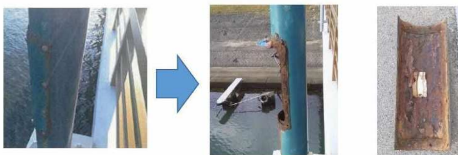
電気設備開口部の腐食が進行した例
