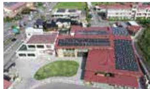
（キナムなんふ）太陽光に加え、南極する施設間を自営線で繋ぐことで自立分散型エネルギーシステムを構築。
