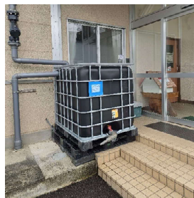
福部総合支所の雨水貯留タンク 個人宅での雨水貯留タンク(鳥取市内)
