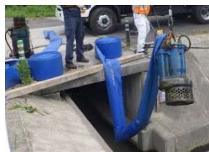
仮設排水ポンプの設置イメージ
