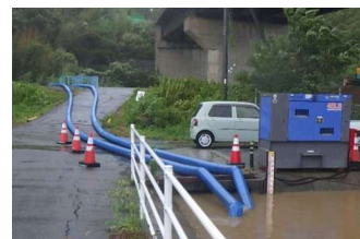
仮設排水ポンプの設置イメージ
