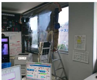
西側面窓遮光フィルム貼付 執務室遮光フィルム貼付
