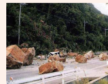
▲崩落した岩石によりふさがれた県道日野溝口線
