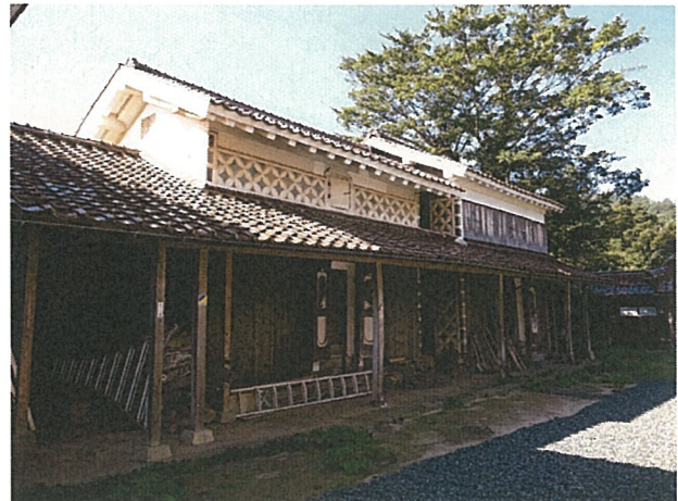
敷地奥に建つ土蔵
