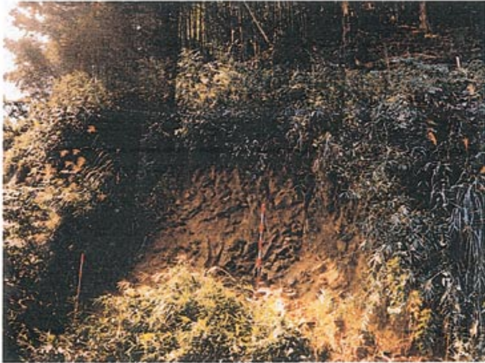
住宅の裏山の崩落(西伯町)
