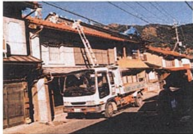
屋根の修繕(日野町)
