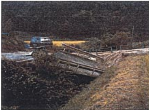
地盤がずれ、外れてしまった橋(西伯町)
