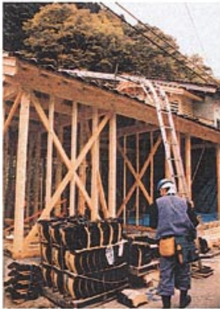
住宅の新築(日野町)
