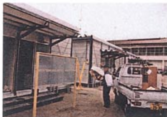
仮設住宅への引越し
