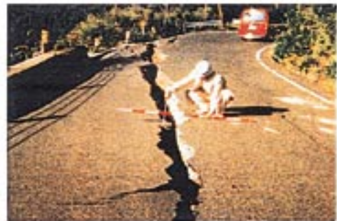
道路に生じた亀裂(江府町)
