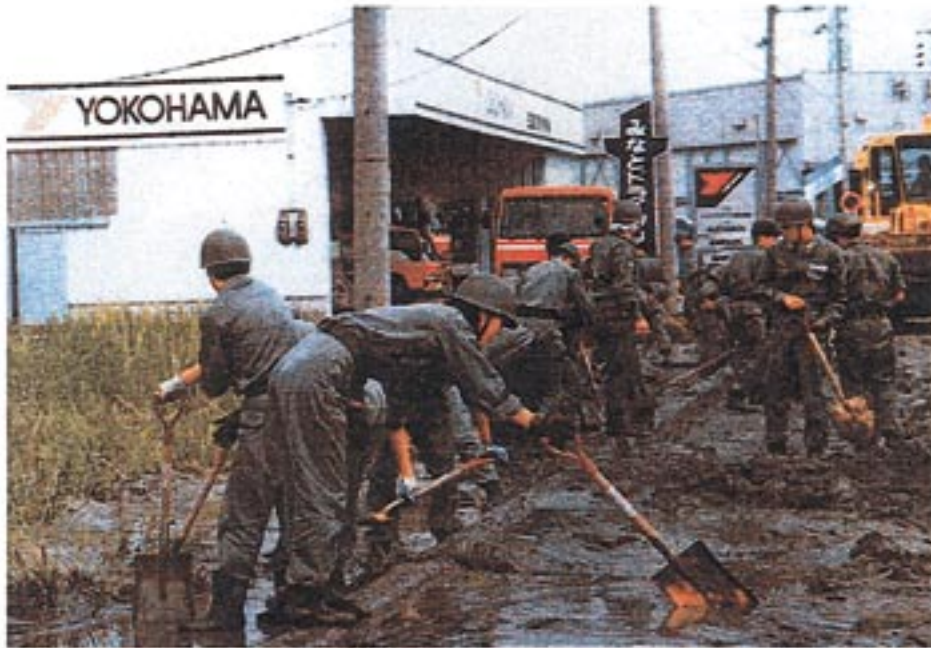
液状化した道路の土砂を撤去する自衛隊
