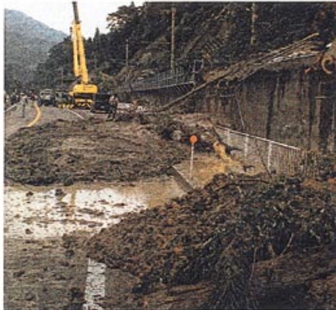
崩落した土石によってふさがれたJR伯備線と道路(日野町) (山陰中央新報)
