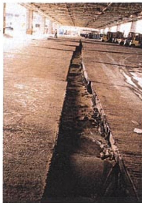
市場内の亀裂(長さ100m、幅0.4m)
