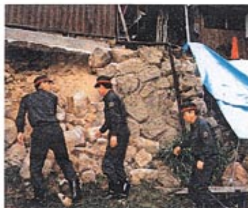
石垣が崩れ落ちた民家を点検する消防団員 (山陰中央新報社提供)
