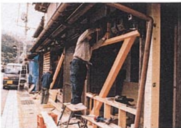
住宅の修繕(日野町)
