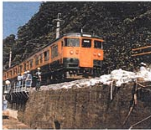
復旧作業が終わり、運転を再開したJR伯備線 土砂崩れ現場を通過する特急列車(日野町) (山陰中央新報社提供)
