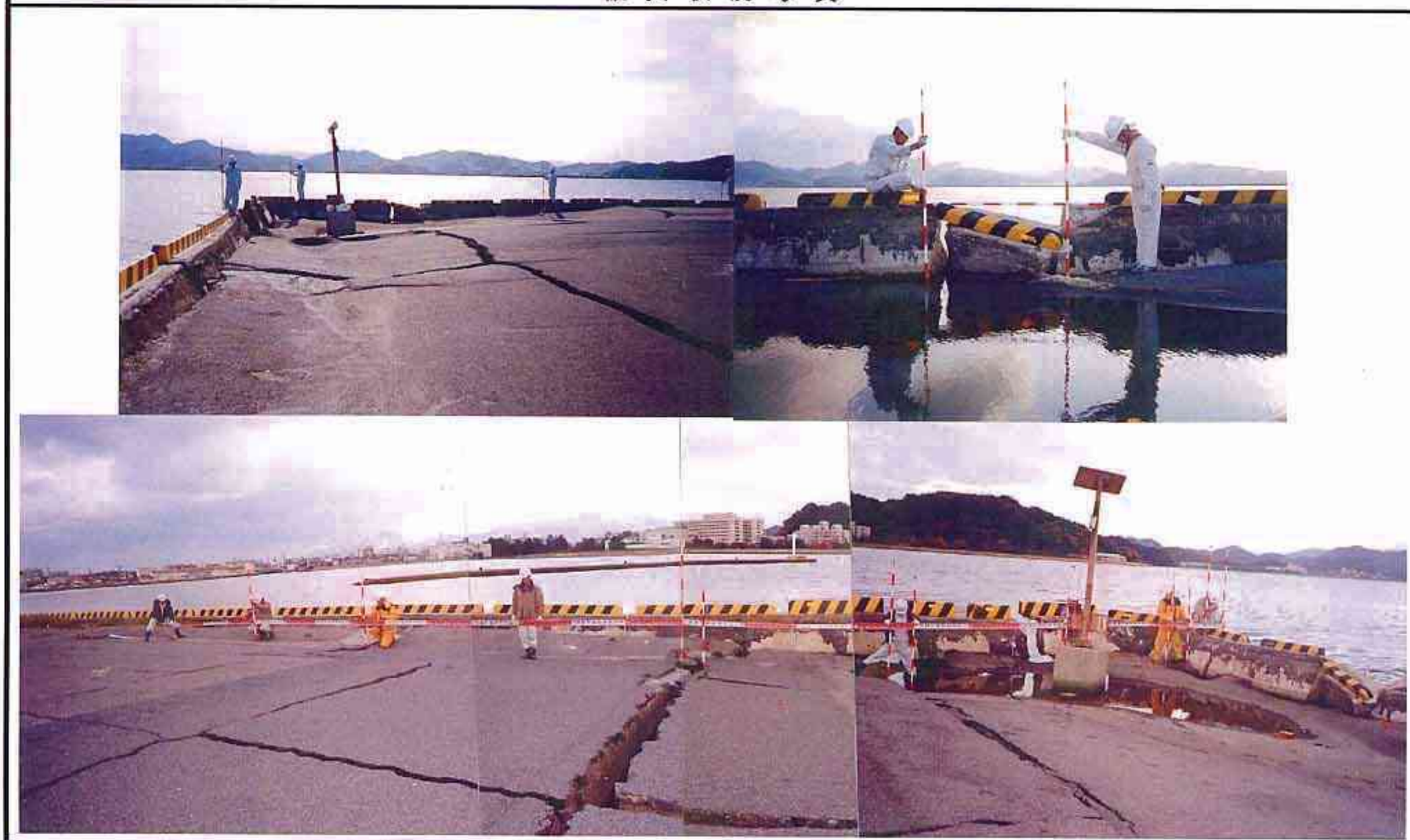
被災状況写真
