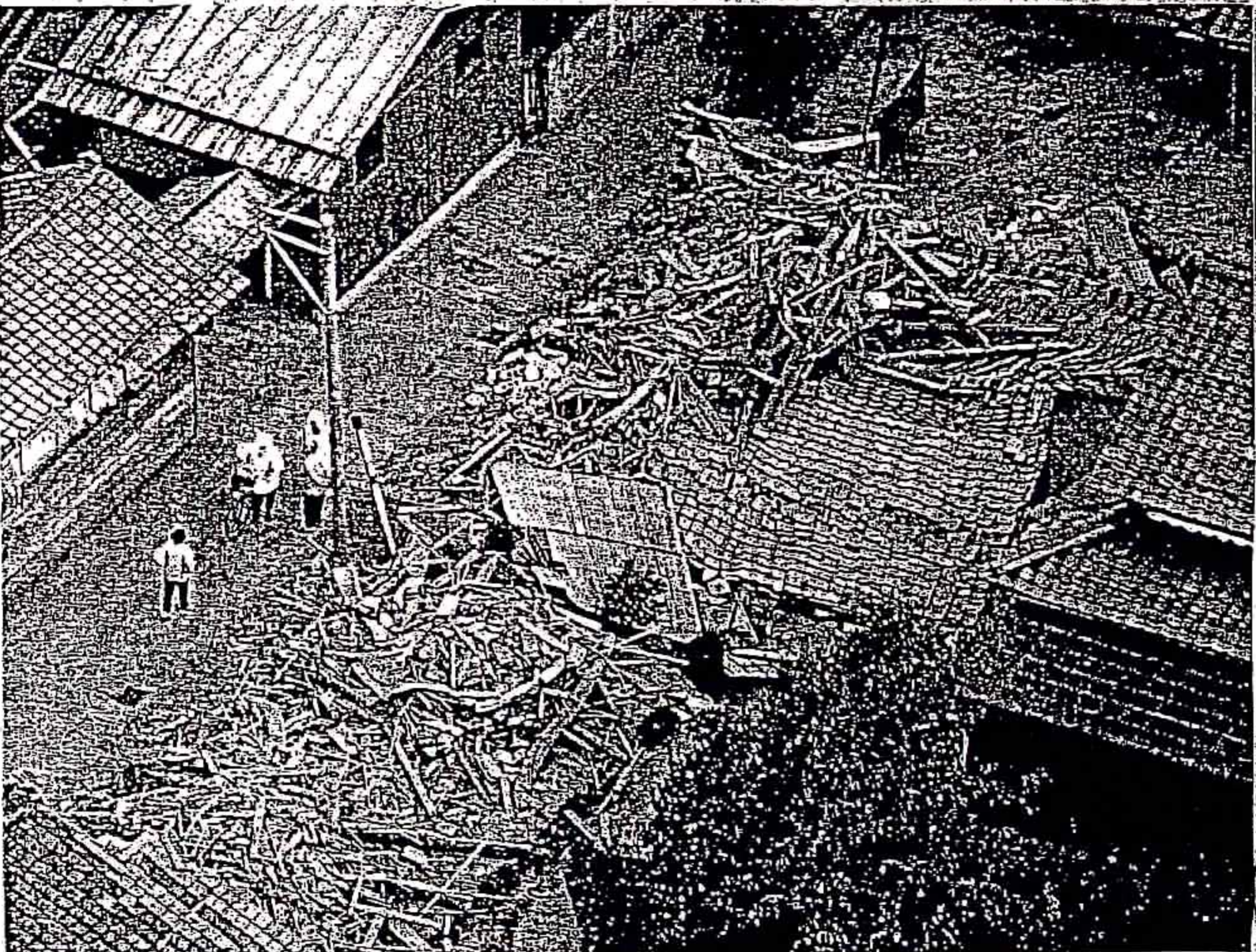
強い地震で倒壊した民家＝6日午後5時20分、鳥取県境港市
