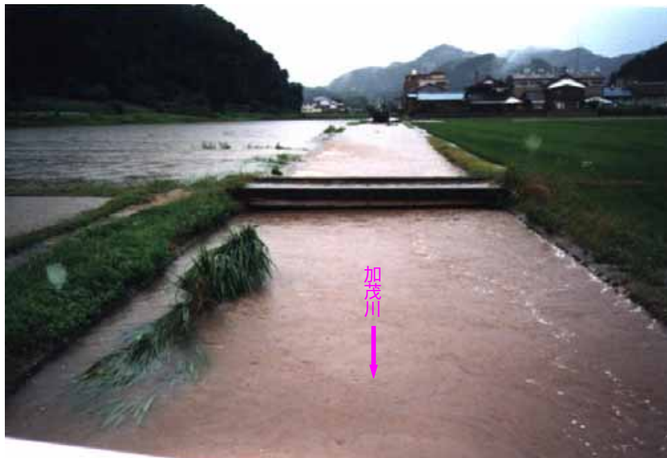
被害状況写真 1-2 加茂川 なつごら 奈喜良地内浸水状況 (S63年7月13日洪水)
