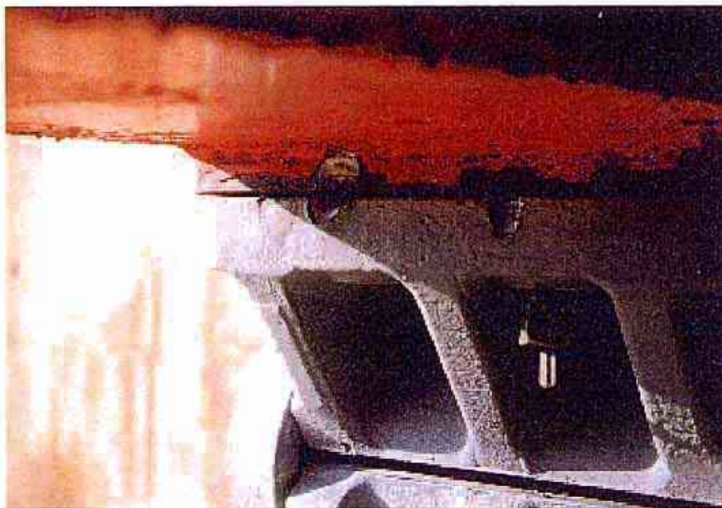
写真 4-3 上沓のボルトきず
