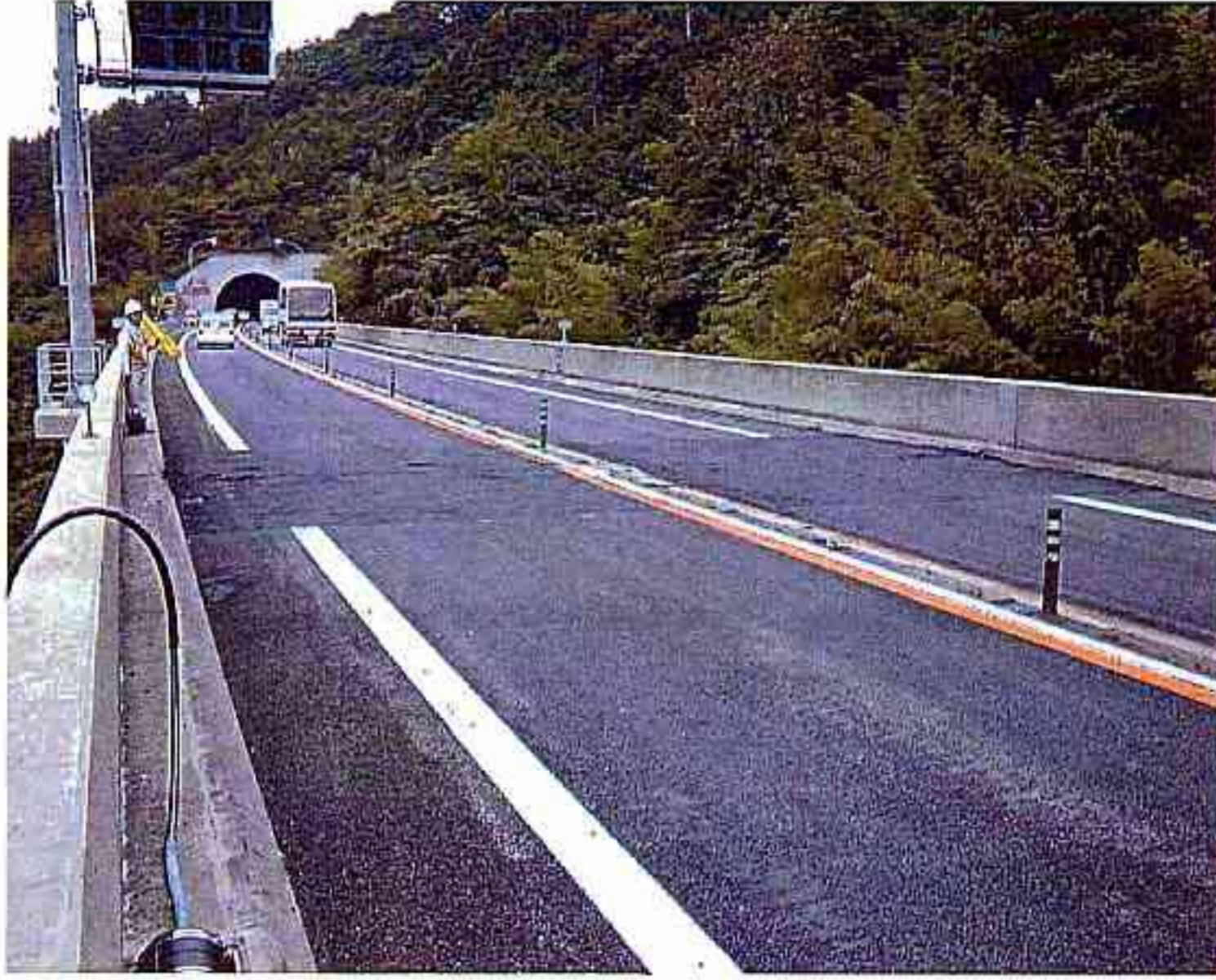
写真 5-14 佐川橋 P5 ジョイント部段差修正
