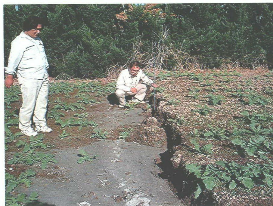
写真-5 開口クラックに見られる噴砂
