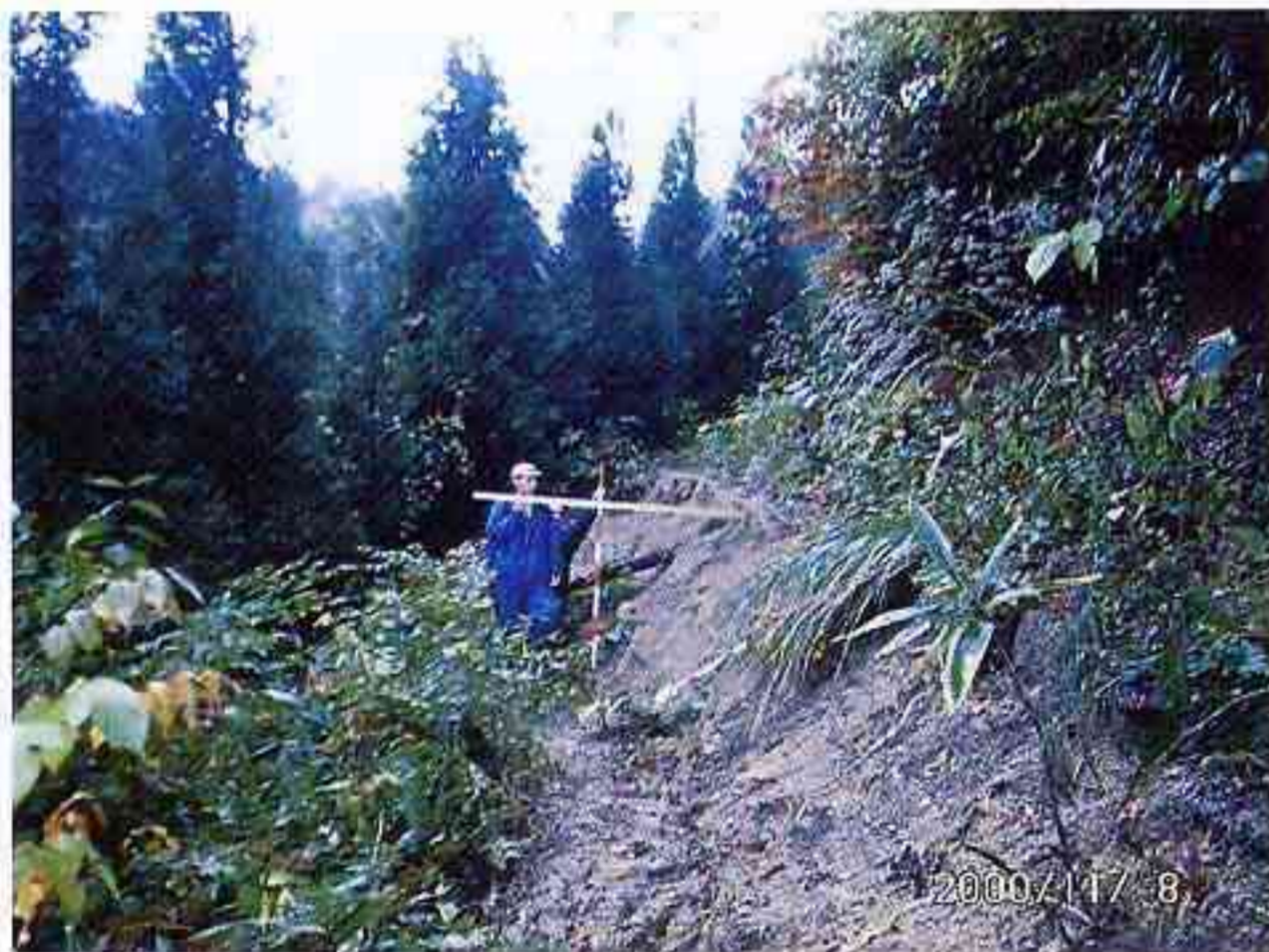
鎌倉山・山腹の斜面崩壊
