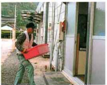
仮設仮設住宅を4か所に24戸を建設（10/30に23戸入居）建設 4戸（県東部地区に2日中）
