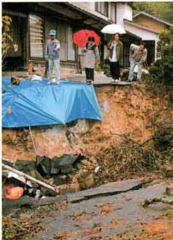
地震の影響で道路に2m以上の段差ができる（下郷地区）
