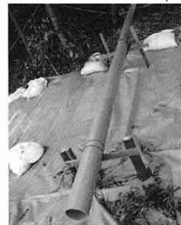
ビニール張り工法 赤崎町 (警報器設置)
