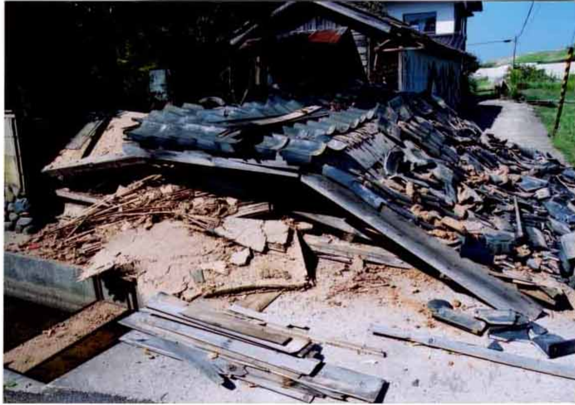
安来市切川町 建物全壊状況
