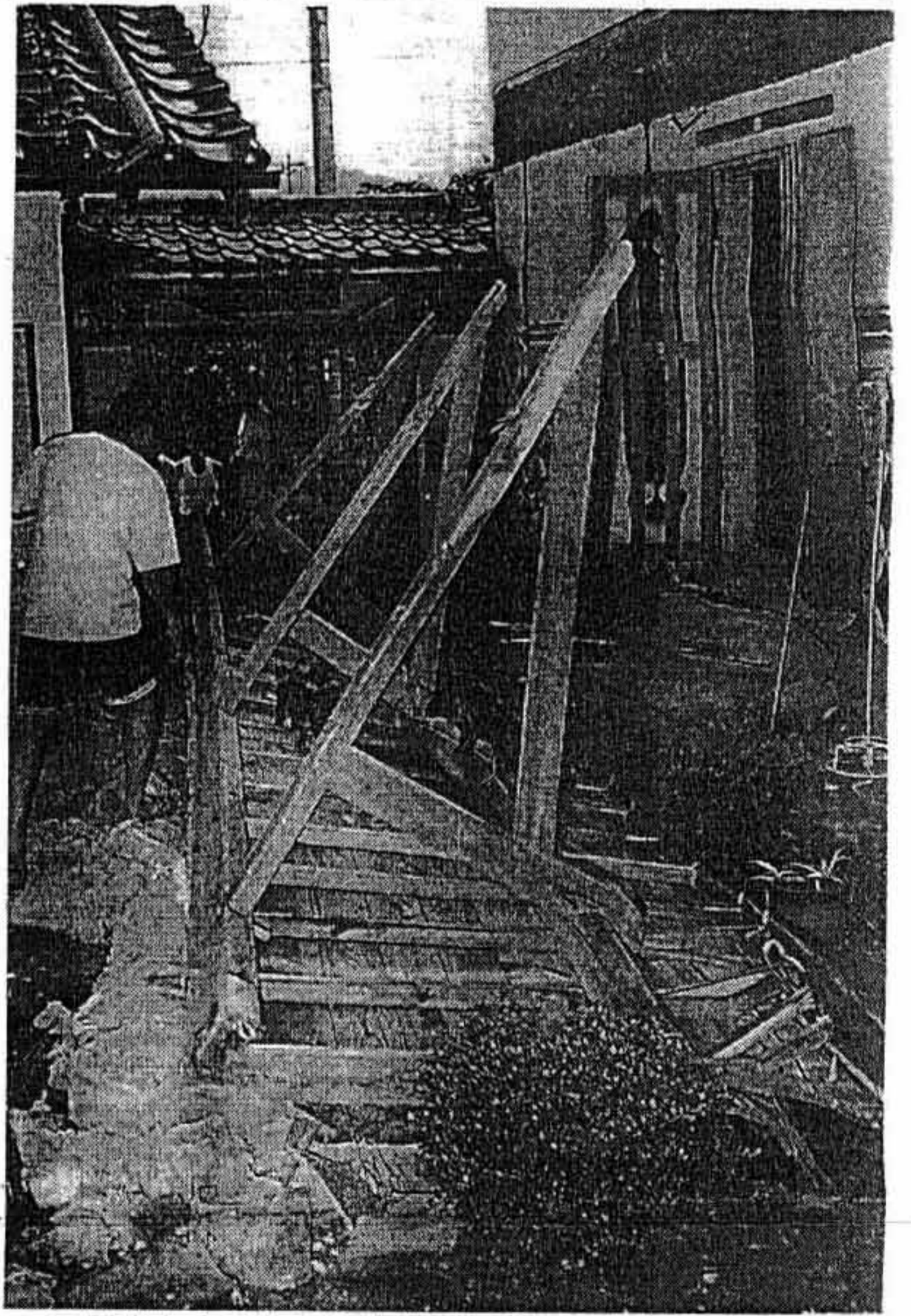
三原さん方であわらとともに落下した土蔵のひさし
