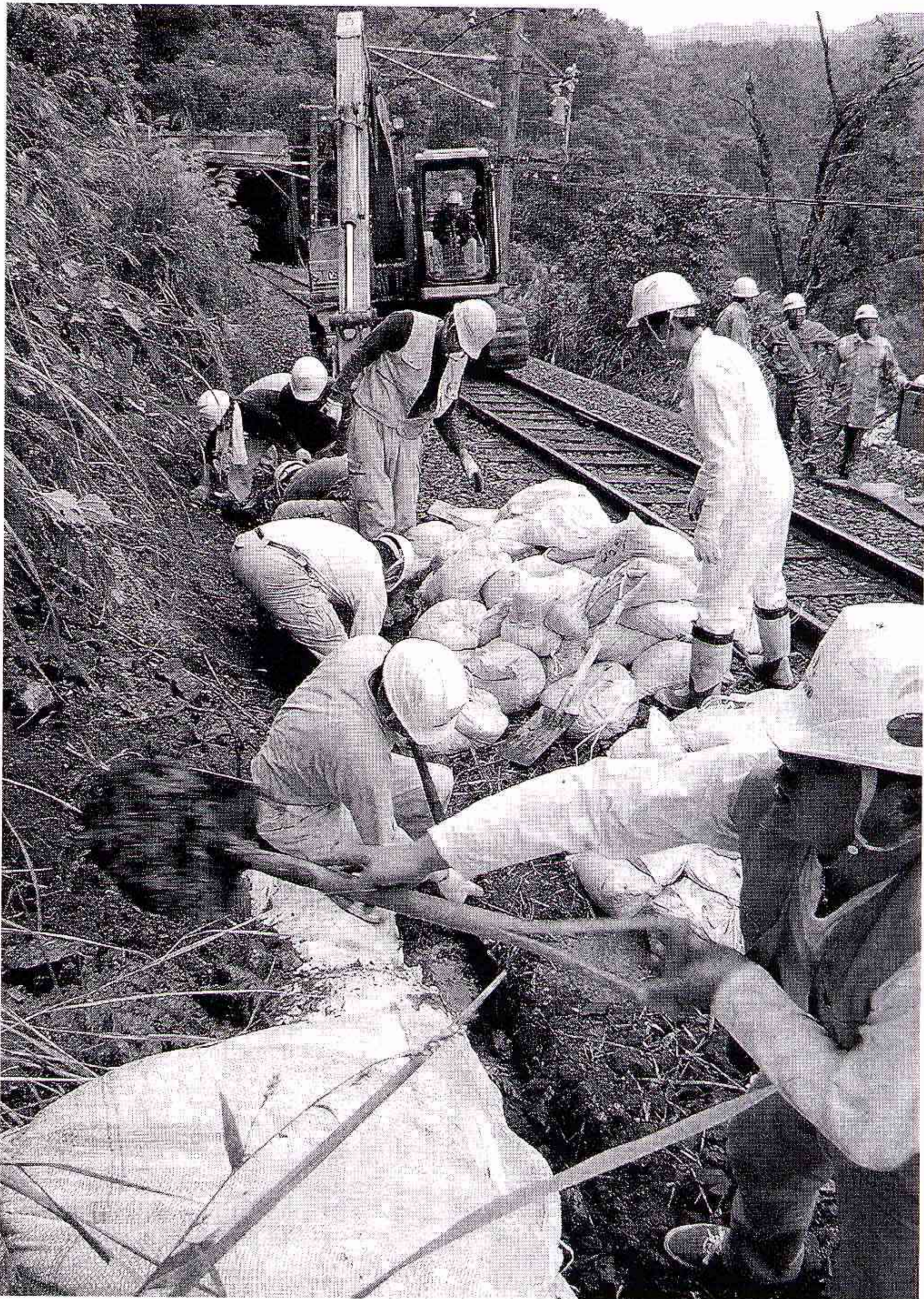
側溝の土を取り除いたり、土のうを積み上げたりして、復旧を急ぐ作業員ら—8日午前10時45分、鳥取県日野町根妻、J R伯備線根妻トンネル付近
