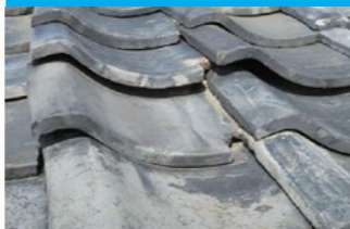
瓦が著しく破損している例
