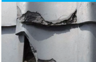
瓦が著しく破損している例
