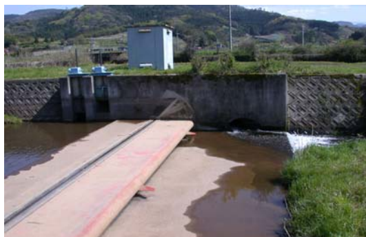
図2 舎人川第一堰堤 (H19.6.4撮影)
