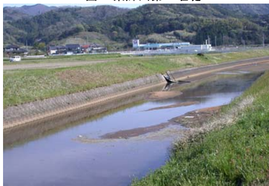
図5 埴見川。側面はコンクリートで固められている。
