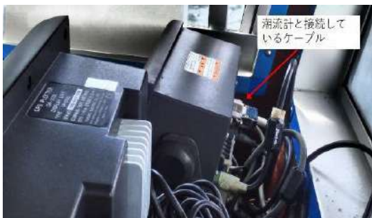
写真 潮流データ収集協力船の船内潮流計と無線機を接続するケーブルを設置
