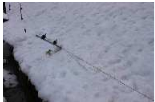
▲積雪で壊れた電気柵
