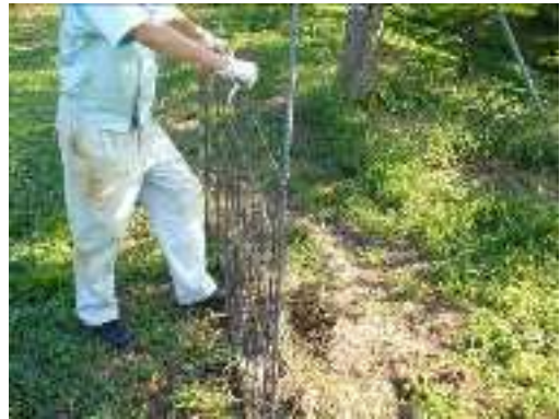
▲結束前に必ず手で押さえ、足で踏み込んでワイヤーメッシュを埋め込む。
