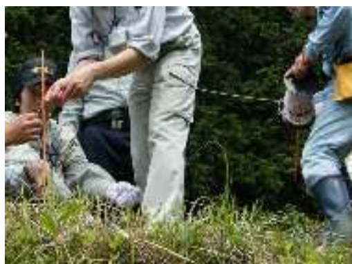
▲支柱に取り付けた碍子に電線を取り付ける。
