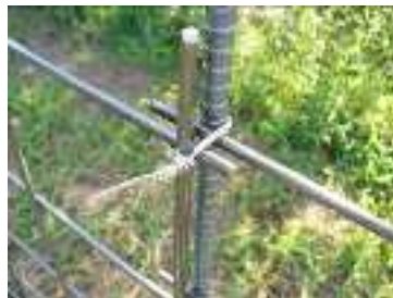
▲ワイヤーメッシュの重なりと支柱には隙間ができないようにする。
