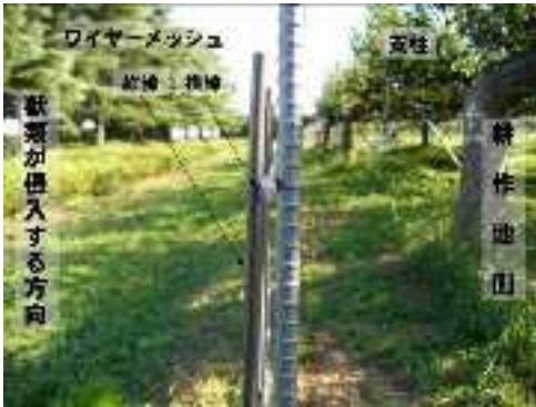
▲支柱が耕作地側になるようにワイヤーメッシュを置く。 ワイヤーメッシュは縦線が獣類の侵入する方向になるように配置する。
