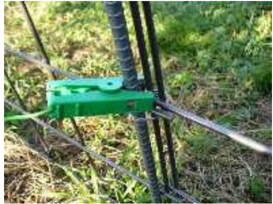
▲ アース棒の代わりに、支柱やワイヤーマッシュにアース線を接続する方法もある。
