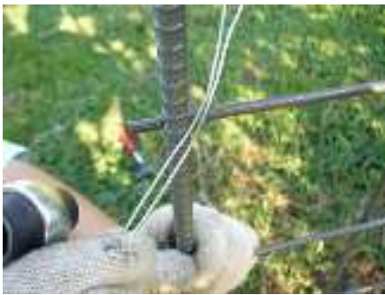
▲結束は針金がメッシュに対して、たすき掛け（針金が斜めに掛かる）になるように固定する。 針金は二重にして使う。
