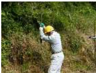
▲打込み器を使った支柱の打ち込み 支柱は深さ30cm以上打ち込む。
