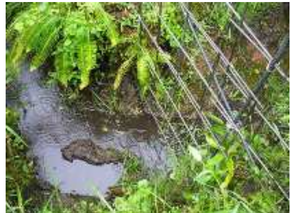
▲水路の工夫（ワイヤーメッシュ柵） やむをえず水路を横断する場合は、増水すると 柵の一部が外れるような工夫も必要となる。
