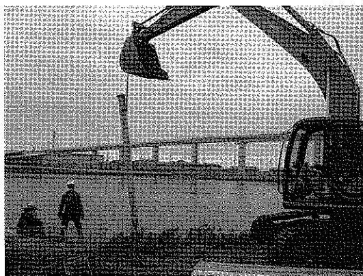
図5 浸漬杭設置状況（境港市の貯木場）
