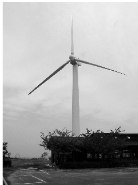
泊村風力発電システム（600kW）
