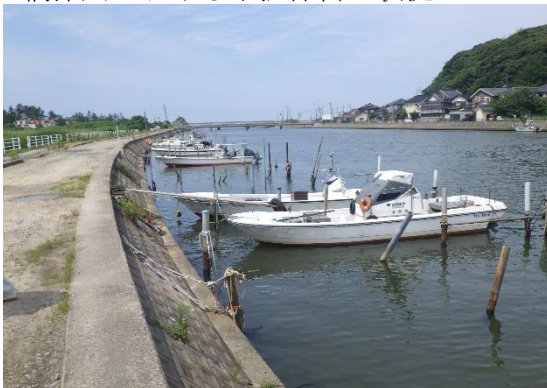
※橋津川における不法係留の状況
