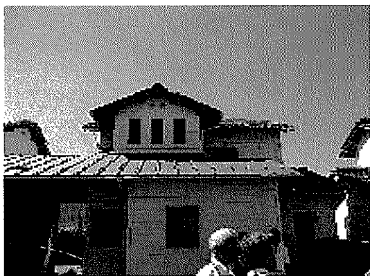
昨夜のうちに屋根、壁の被災部分は応急措置を行った。
