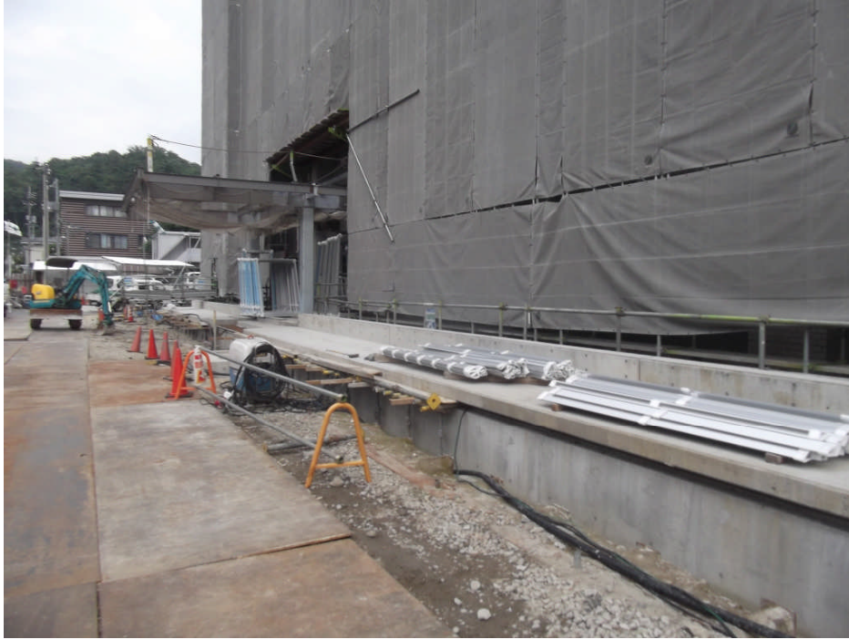
① 本庁舎（北面より）
