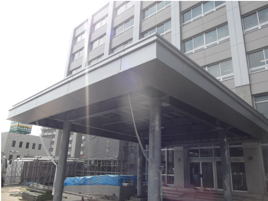
② 南面正面玄関キャノピー
