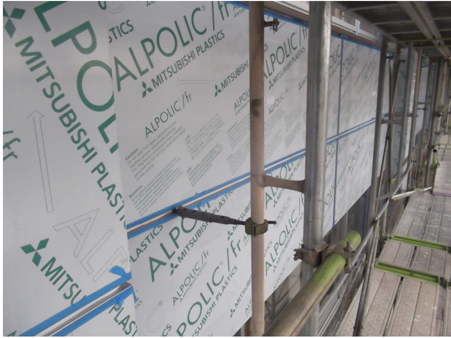
⑤ 北面7F～4Fパネル取付状況
