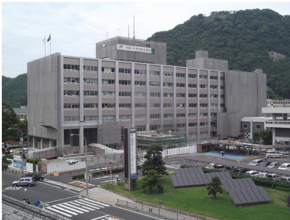
本庁舎（南面より）
