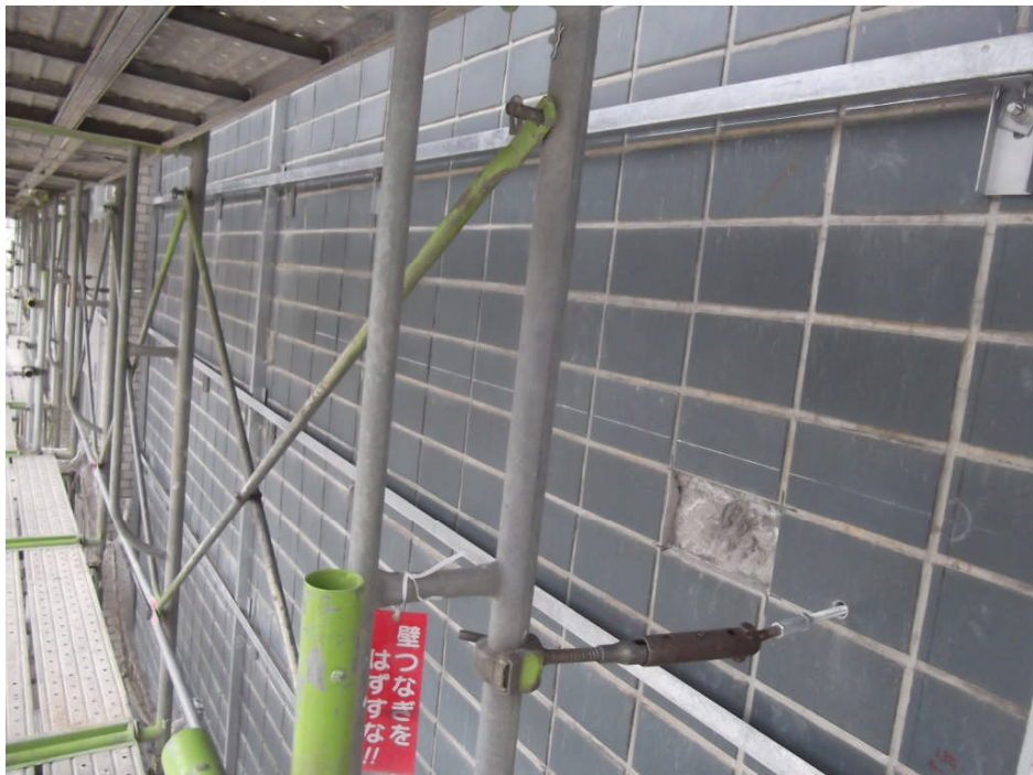
④ 東面パネル下地取付
