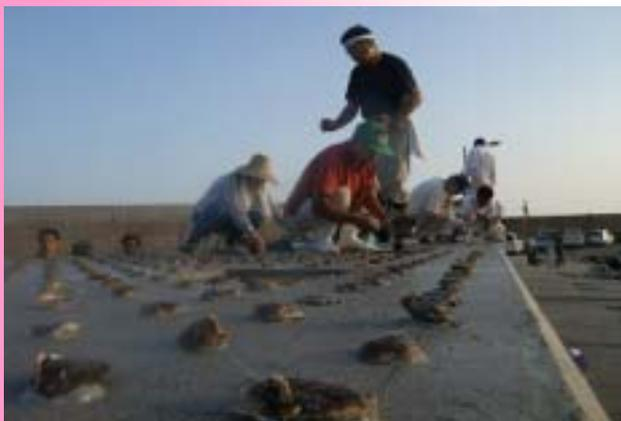
写真1 根固方塊の天端への貼付作業
