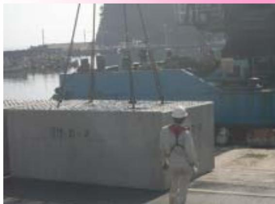
写真2 根固方塊を沈設するため台船に搭載追跡調査！！
