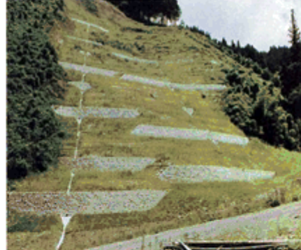
崩壊地の復旧を図るため、山腹工を実施し森林の機能回復を図った。 (昭和49年)
