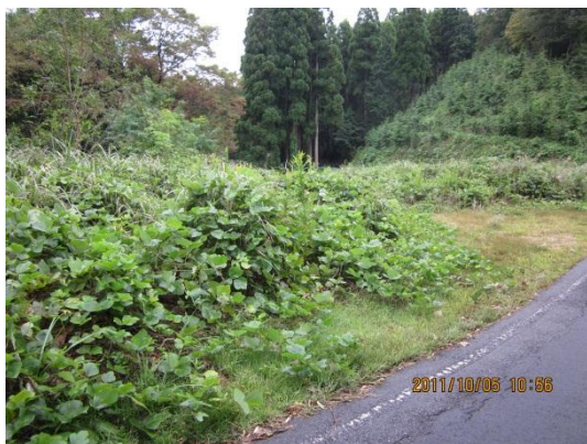
(注) 盛土工事施工済部分
