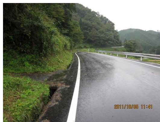
(注) 拡幅工事施工済部分
