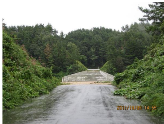
(注) 左写真の奥の部分（奥が舗装工事未了の橋梁 りょう であり、更に奥の山林が長期未着工用地）
