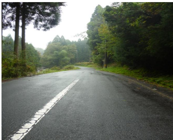
(注) 画面奥、それまでの片側一車線から車線が減少し、隘路 あひ となっている。
