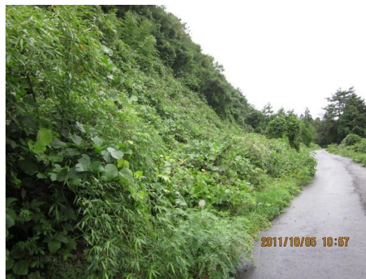
(注) 切土工事施工済部分
