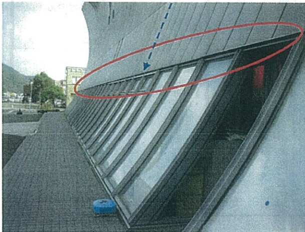
写真2 撮影箇所: サッシ上部 水切
