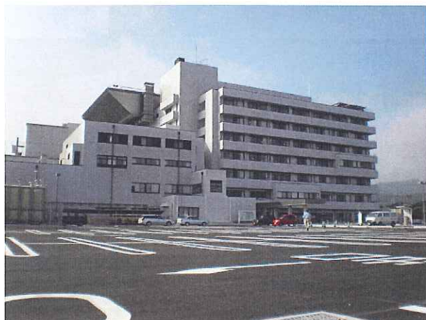
← 新たに整備した北側駐車場(227台収容)
