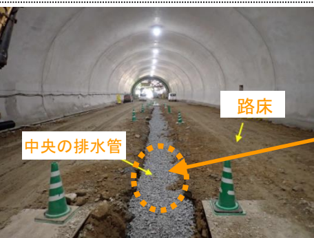
中央排水管施工中
