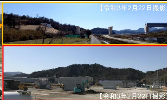
浦富東工区では、浦富高架橋を支える橋脚工事がほぼ完了し、完成したキレイな橋脚が姿を現しました！また、東側では牧谷トンネルにつながる山切及び盛土工事も進んでいます！
