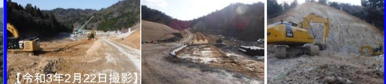
大雪の影響もあり、牧谷トンネルの掘削着手が少し遅れていますが、トンネルの掘削準備のため工事用道路や施工ヤードの整備が進んでいます(写真①)。
