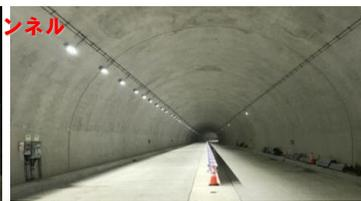
浦富IC～牧谷トンネル区間では、アスファルト舗装工事が完了し、中央分離帯のガードレール設置も概ね完了しました。現在、区間線工事の準備や浦富IC周辺の大型標識設置の準備が進んでいます。
