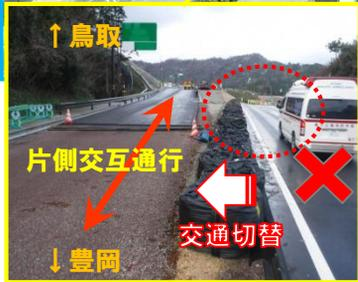
1/16日からの交通切替では、しばらくの間、左上写真の黄色点線範囲において、片側交互通行を行いながら、残り（左写真の赤色点線範囲）の盛土工事や水路設置などを行い、東浜居組道路との接続部分を仕上げしていきます。
