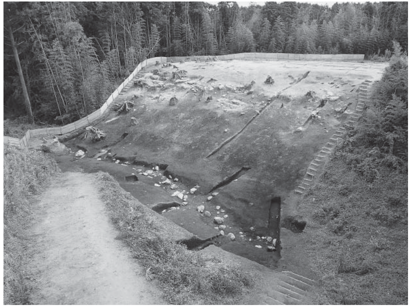
1 3区完掘状況(南西から)
