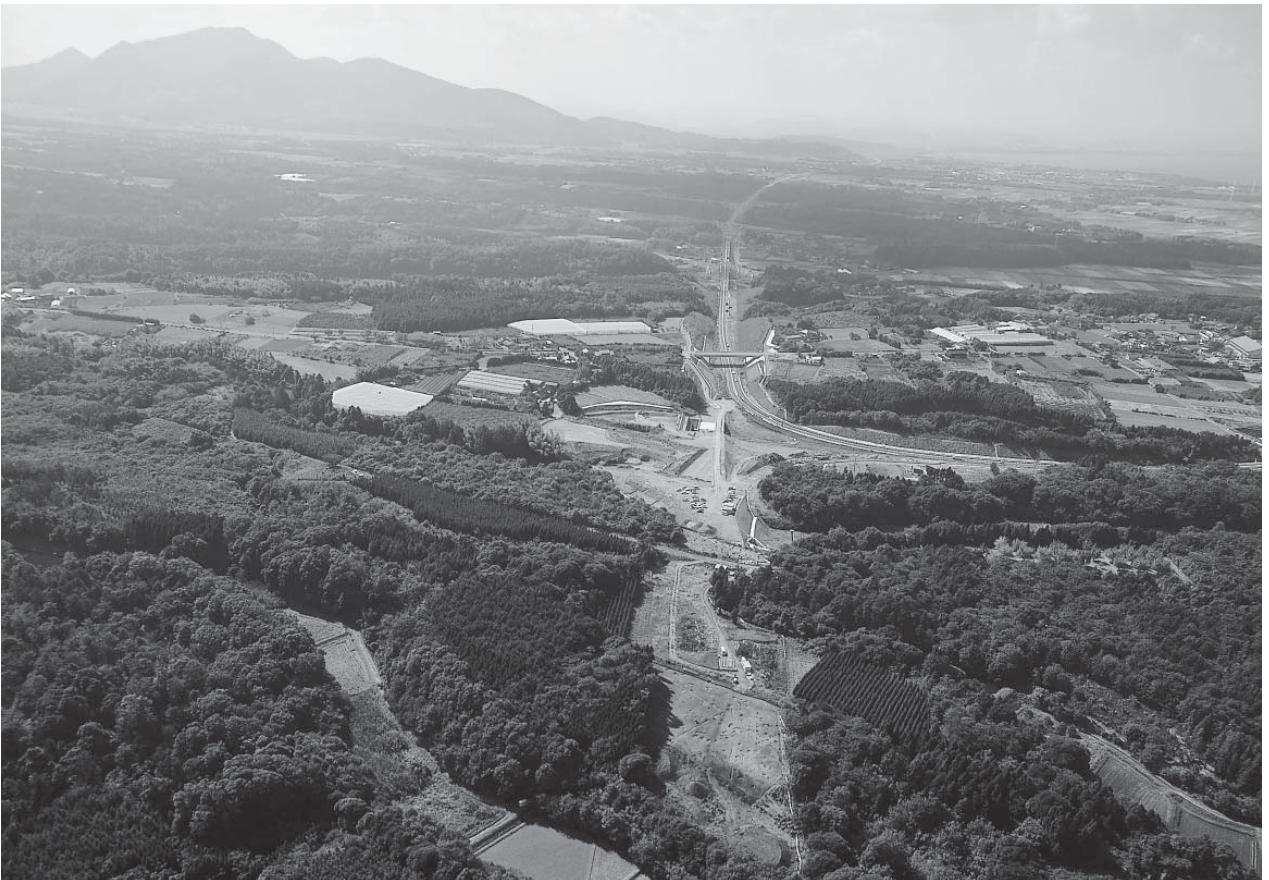
2 調査地周辺の地形(東から)
