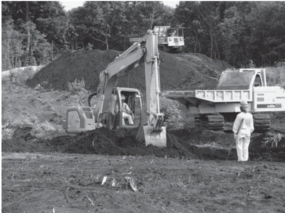
写真4 西坪下馬駄ヶ峰遺跡表土剥ぎ風景
